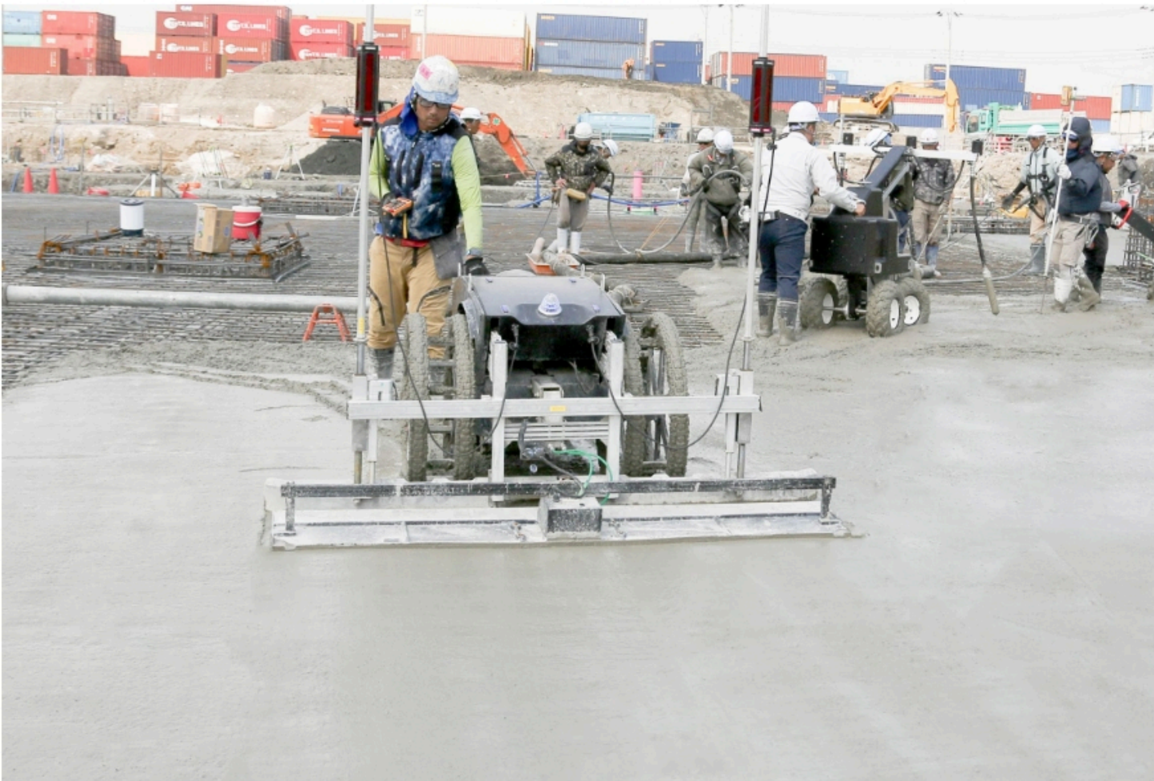
①大型物流倉庫の土間コンクリート打設
