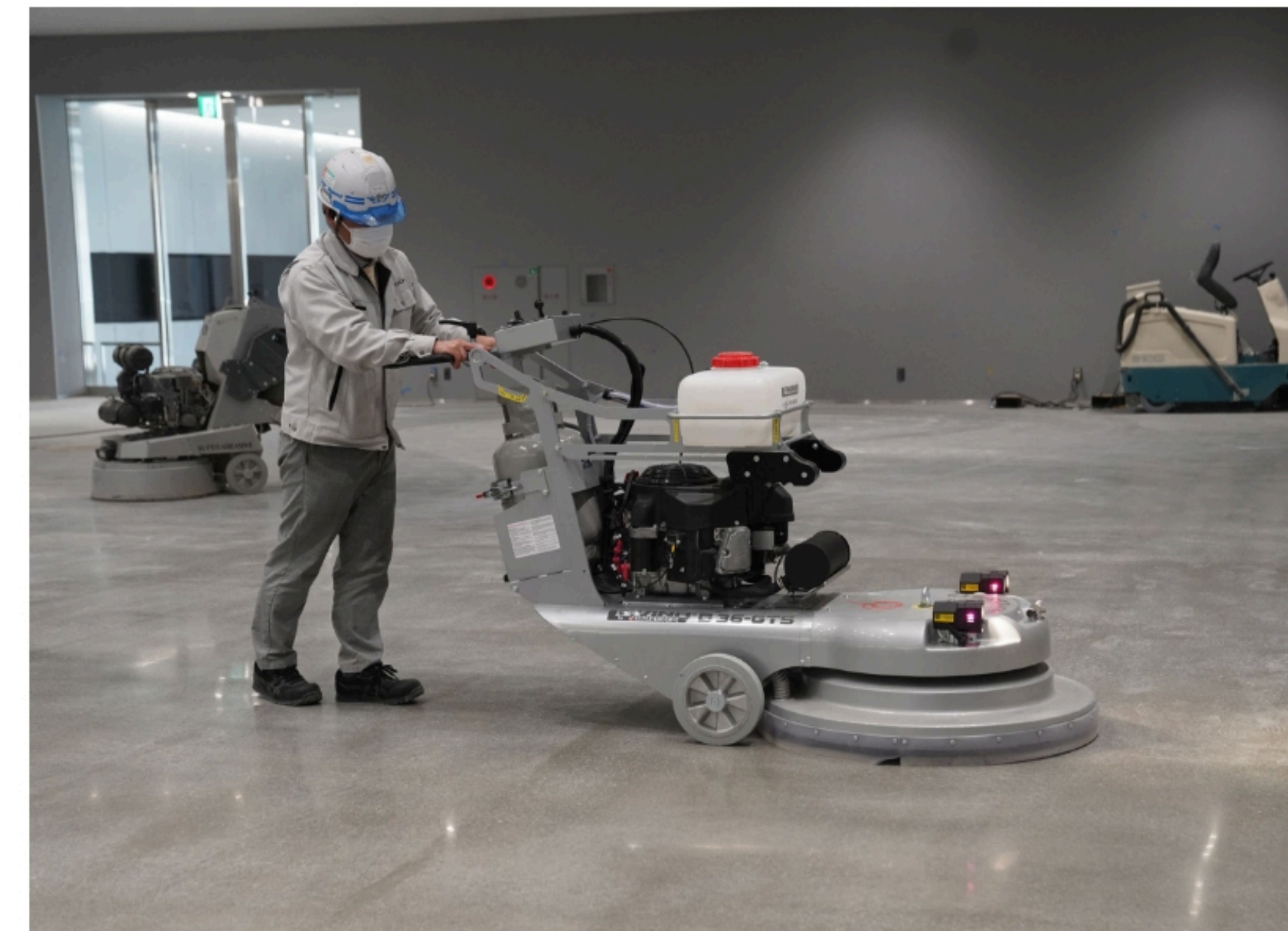
①工場的美装研摩工事(鏡面ポリッシュ)
