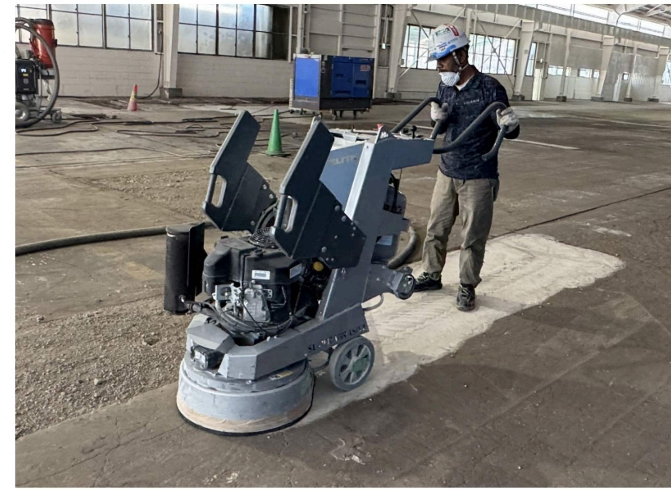
①工場の原状回復にともなう下地調整研磨工事
