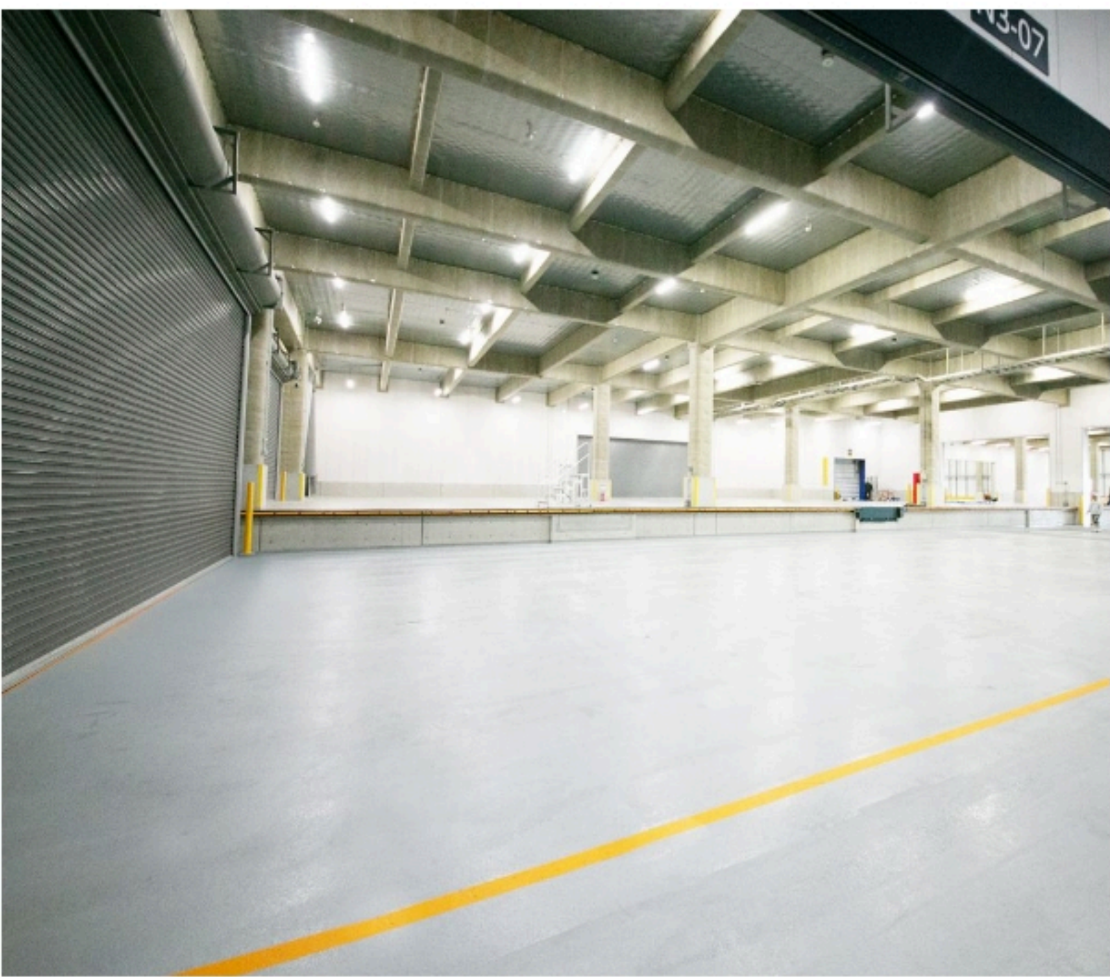
③施工後の床面
